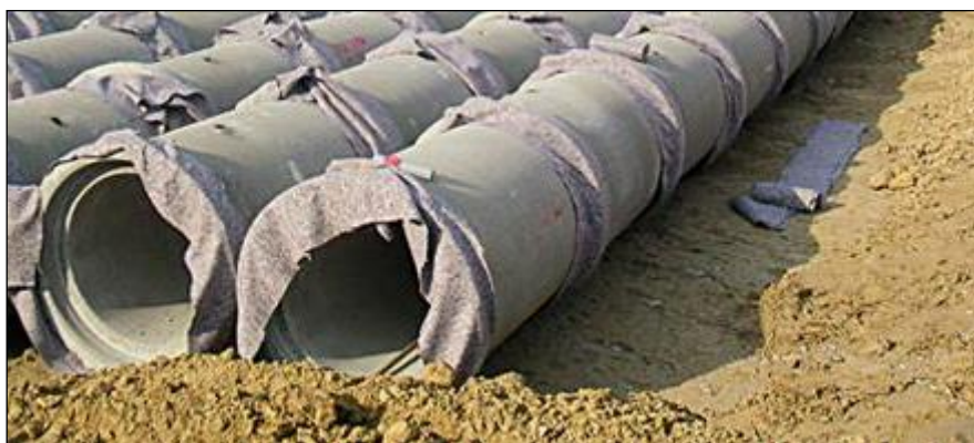
Figura 8-10: tubazioni sovradimensionate per invaso
