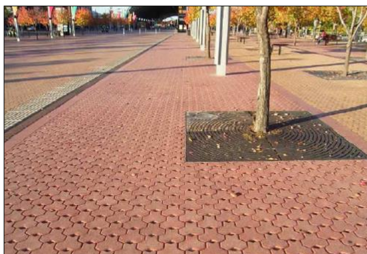
Figura 8-6: pavimento in betonelle drenanti
