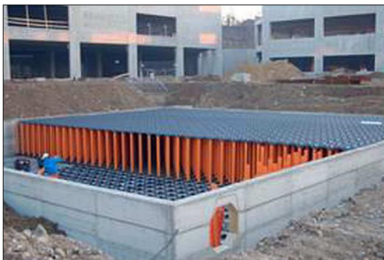
Figura 8-9: vasca di invaso interrata
