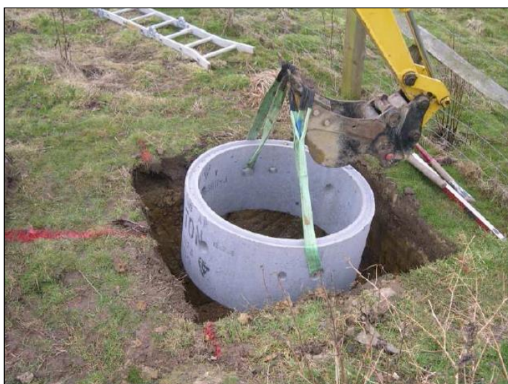
Figura 8-3: pozzetto disperdente
